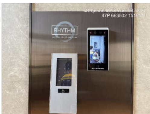
รูปที่ 41 ระบบเข้า-ออก อาคารด้วยการสแกนใบหน้า
